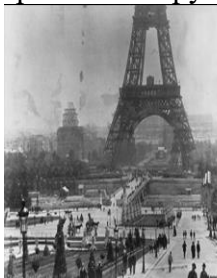
Несущим стальным конструкциям для зданий с самого начала пришлось остро соперничать с бетонными и каменными. Сталь применяли только тогда, когда свойства общепринятых материалов были недостаточными. Примером может служить Эйфелева башня в Париже. В то время невозможно было возвести подобное сооружение из бетона. Развитие сварочной технологии изменило отношение к ней. Значительное сокращение стоимости производства и времени изготовления сделали стальные конструкции конкурентоспособными во многих областях. Экономичное превосходство сварных конструкций стало очевидным.
