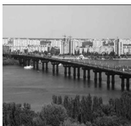
Мост Патона. Первый в мире полностью сварной (без единого болта) мост.
