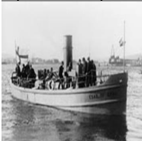
После Первой мировой войны в Швеции было сконструировано и построено 16-ти метровое судно «ESAB IV», демонстрирующее все особенности цельнометаллической конструкции корпуса корабля. По этому проекту во Франции был построен 20-ти метровый корабль «SAF 4», а в Японии спущен на воду «Suwa Маш».
